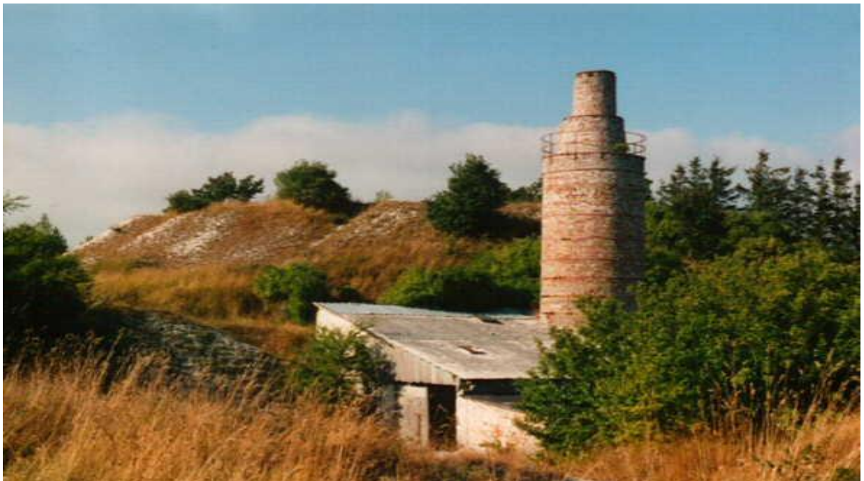
Kalkovnen i Klim før restaureringen (foto Lissa Lomholt).
