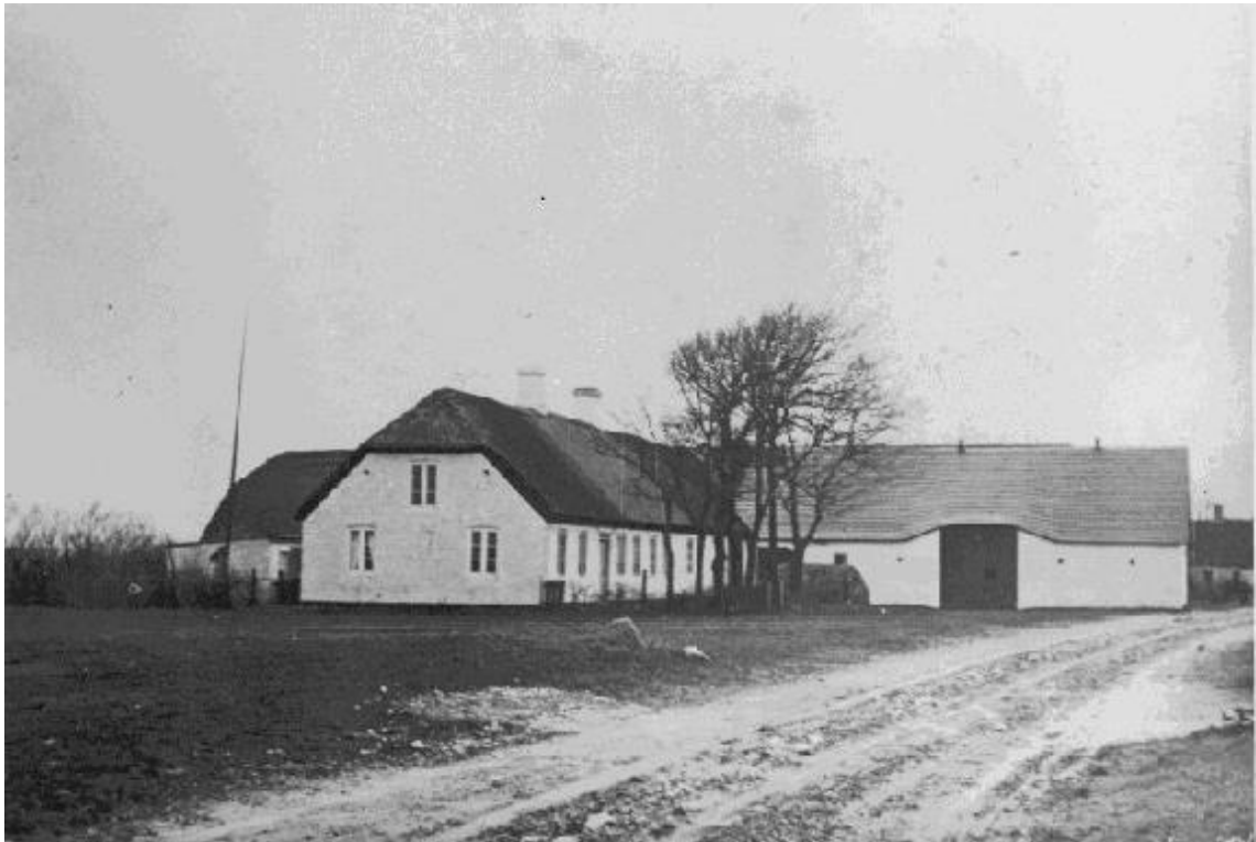
Matr. nr. 30 o. 1910. Det gamle stuehus er fra 1860, mens stald og lade er fra 1900.
